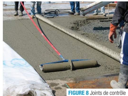
FIGURE 7 Mise en place du béton drainant
