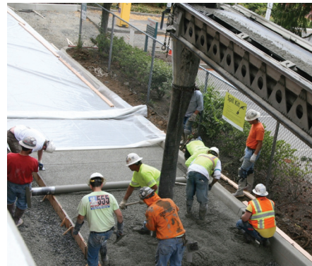
FIGURE 7 Mise en place du béton drainant
